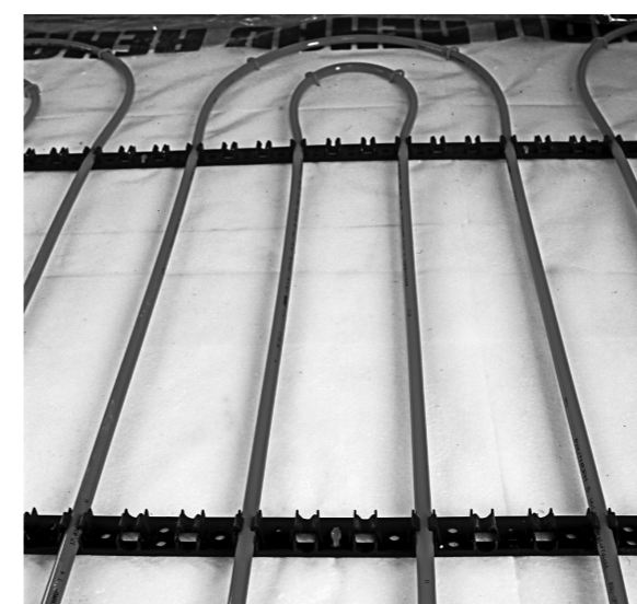
Рис. 154 Система RAUFIX
