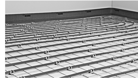
Рис. 163 Система крепления труб на арматурной сетке
