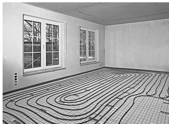
Рис. 145 Система крепления труб с помощью гарпун-скоб
