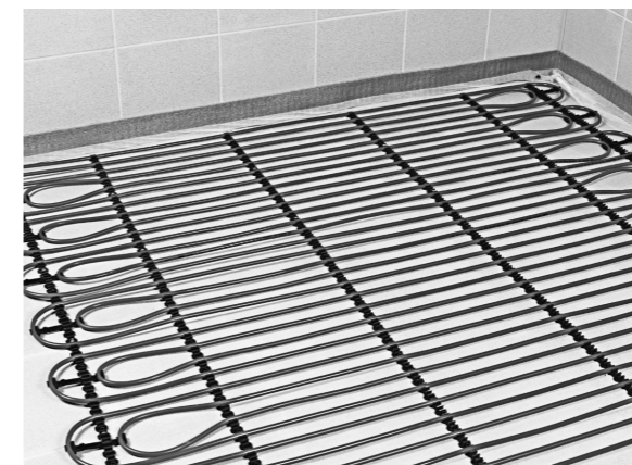
Рис. 180 Напольная фиксирующая шина для «мокрого» способа монтажа
