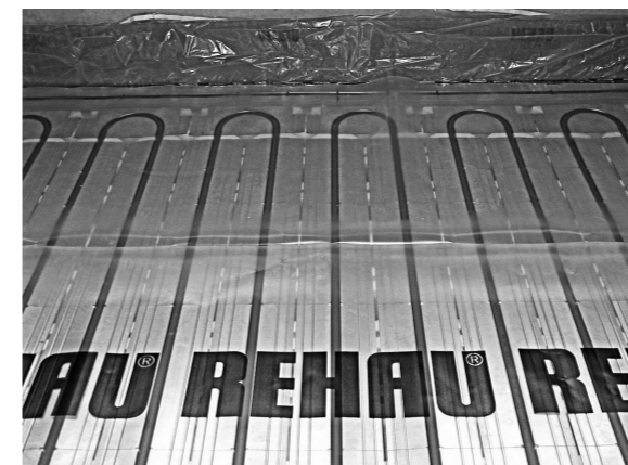
Рис. 186 Система укладки труб на теплоизоляционных матах TS-14
