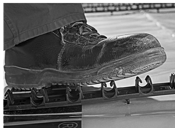
Рис. 158 Вдавливание фиксирующих шин RAUFIX в конструкцию пола
