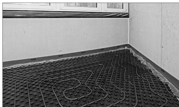
Рис. 134 Маты с фиксаторами Varionova с шагозвукоизоляцией 30-2 снизу
