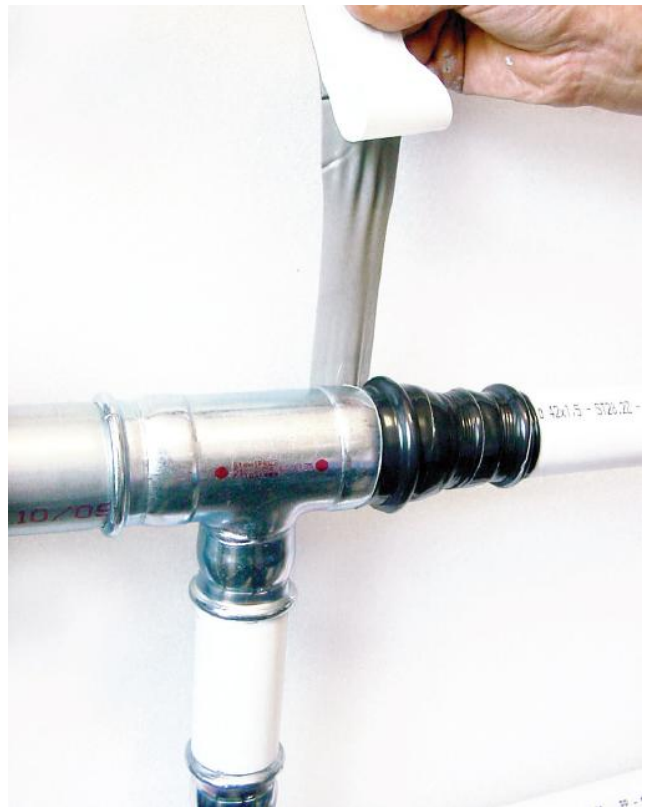
Рис. 38. Защита соединений с помощью бутаноловой клейкой ленты.
