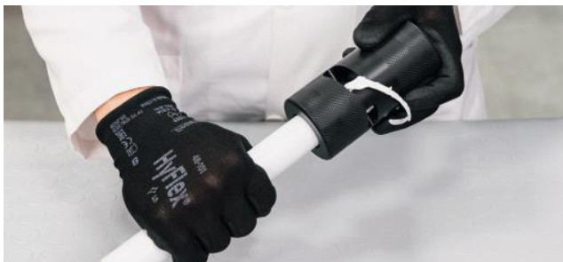
Рис. 29. Резка (труба steelPRES в изоляции из полипропилена).
