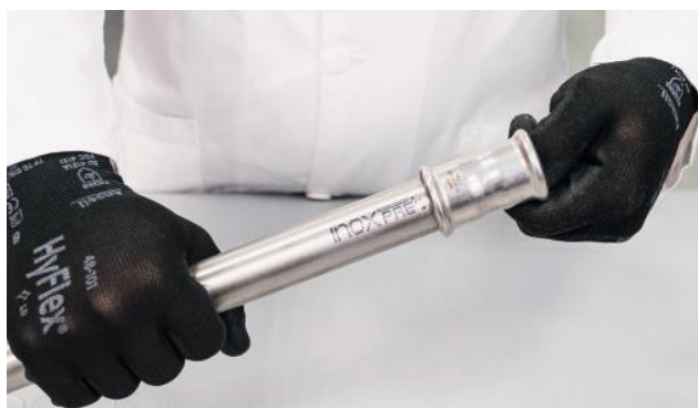
Рис. 31. Вставка трубы в пресс-фитинг.
