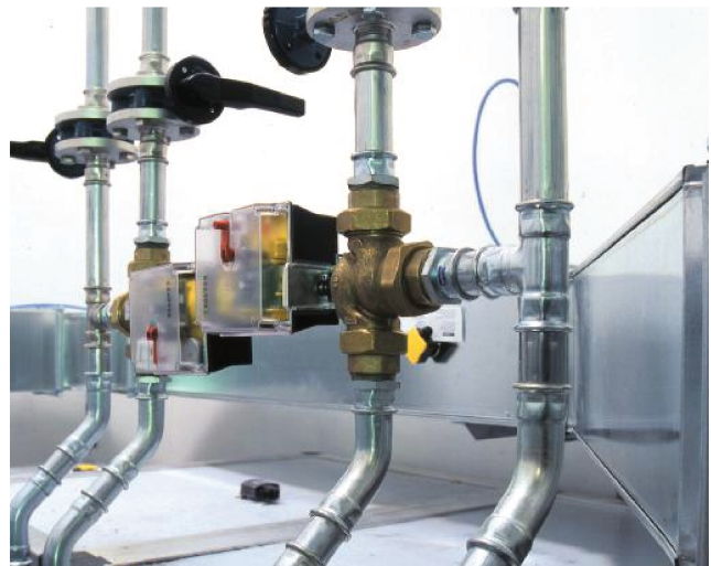
Рис. 22. steelPRES — контур охлаждения.
