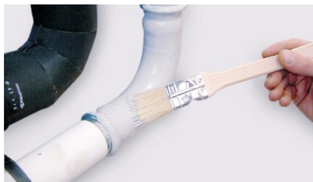
Рис. 37. Покраска соединений и труб праймером.
